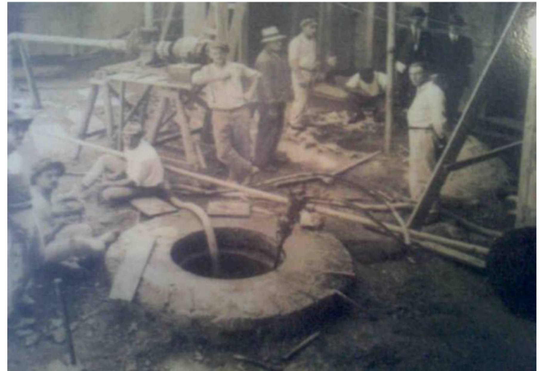
Construção da captação do fontanário (1882)
